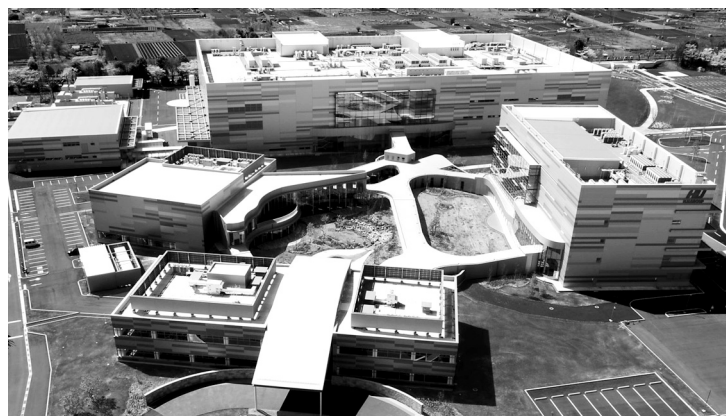
「H.U.グループホールディングス」が運営する「H.U. Bioness Complex」の検査ラボ棟、R&D(研究開発)棟、管理棟、厚生棟の4棟(4つのCube)と回廊(シナプス)等からなり、グループ「H.U.グループホールディングス」の新たな価値の創造を象徴する中核施設だ。検査能力は一日数十万件で、現在の従業員数は約1千人。基礎研
